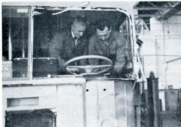
*Ce véhicule a eu le coin gauche défoncé par un tamponnement, M. H. Depas et A. Hoffman vérifient la mise en place du tableau de bord.*
