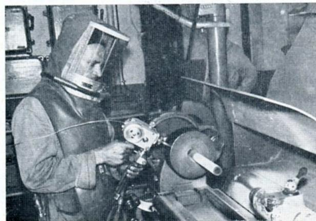
*M. F. Thiry projette un métal d'apport sous la forme d'un fil métallique qui fond à la sortie du pistolet; la gouttelette de métal est soufflée sur la pièce par air comprimé. On utilise ce procédé lorsqu'une pièce n'a plus ses cotes d'origine ou lorsqu'on veut éviter une porosité.*
